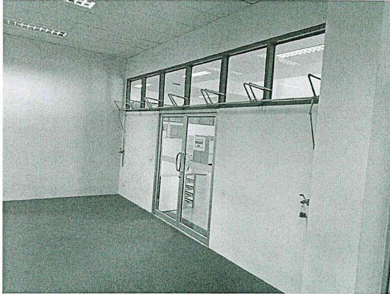
รูปที่1 แสดงการปิดช่องกระจกเดิมและรื้อถอดโครงเหล็กยึดกระจก
